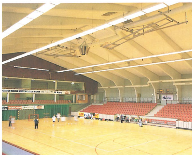
Dagsljus- och närvarodetektorer styr belysning från Fagerhult i Eskilstuna Sporthall.
