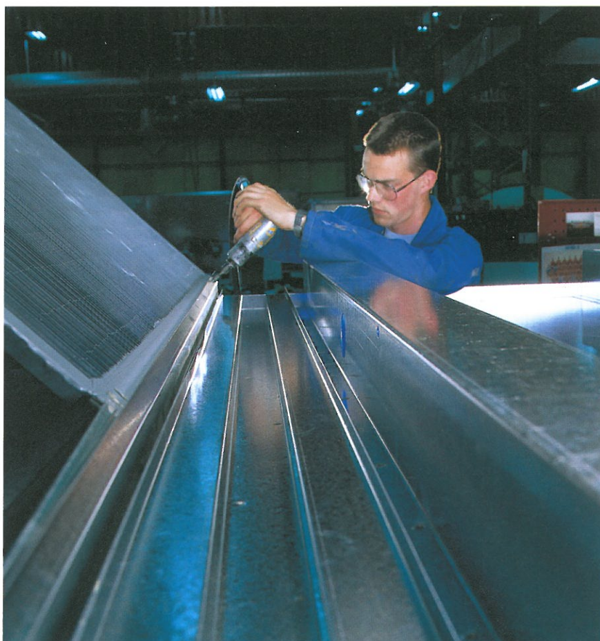
Montering av större ventilationsaggregat.
