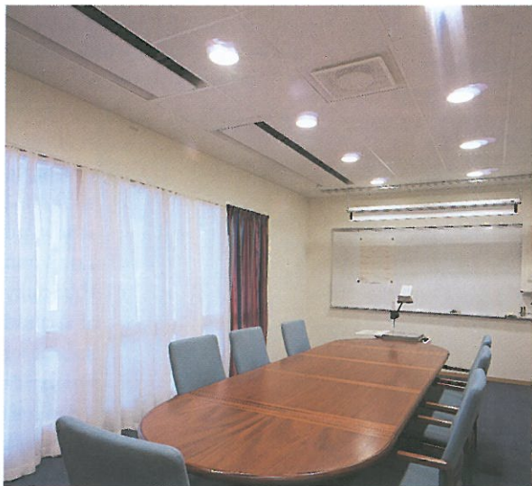
Stifab Farex takapparater för distribution av värme och kyla
