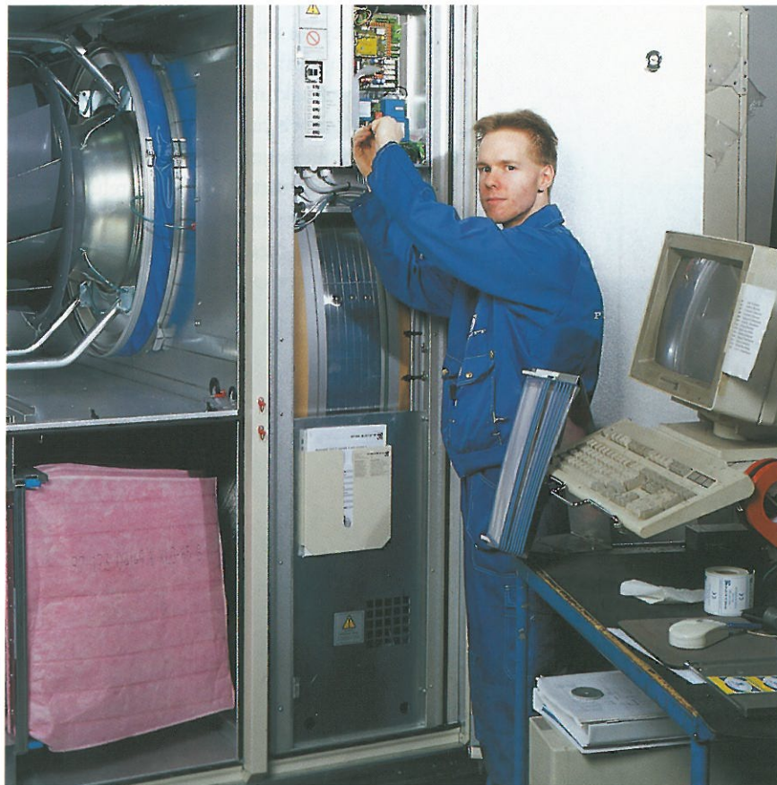
Montering av GOLD-aggregat
