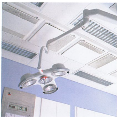
Tilluftsdon för operationsrum vid Astrid Lindgrens barnsjukhus i Stockholm.
