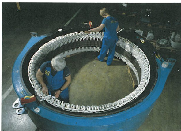
Reparationsarbeten i en generator till ett större kraftverk.
