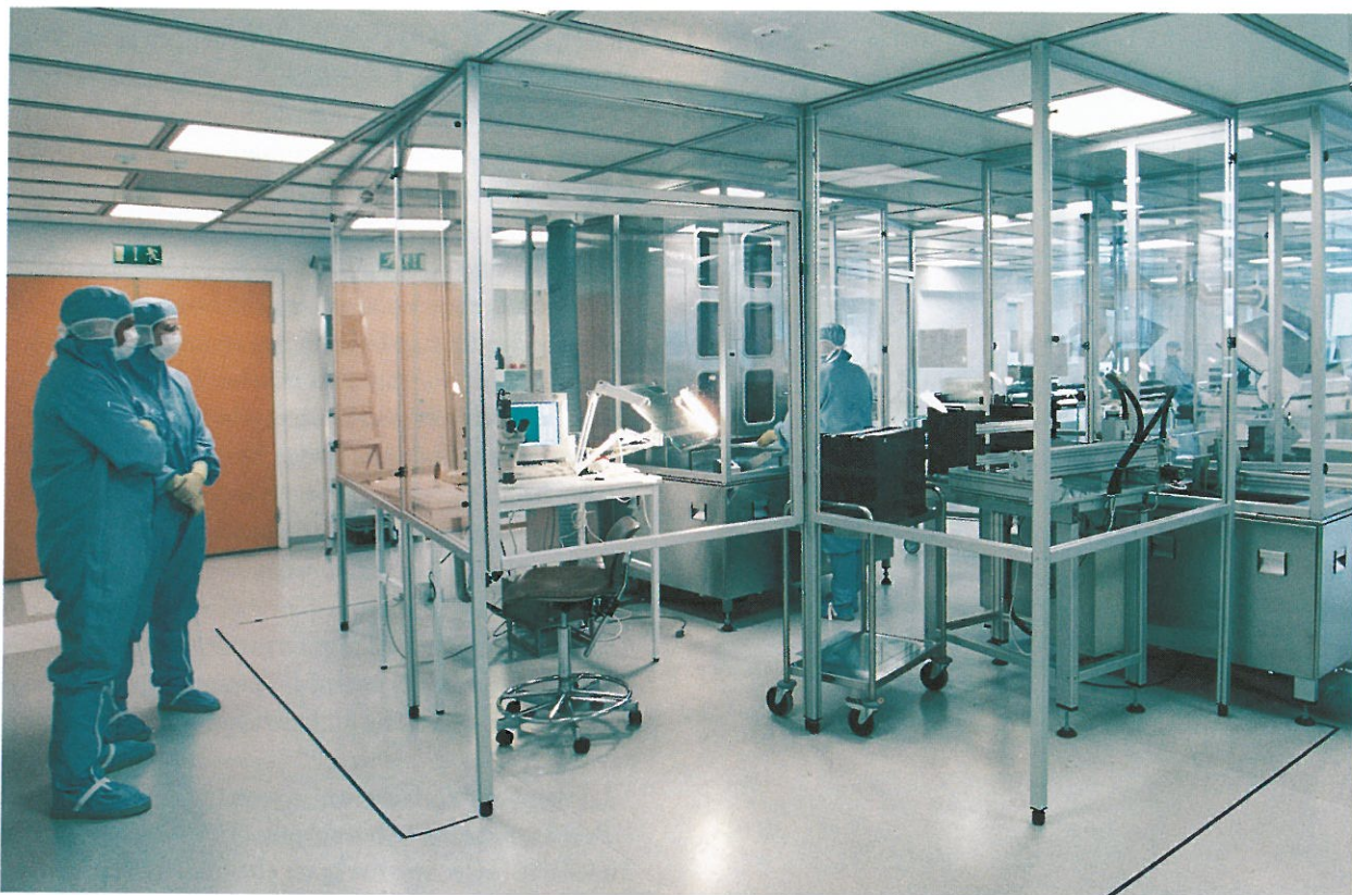
Interiör från renrumsmiljö med filtreringsanläggning från IF Luftfilter.
