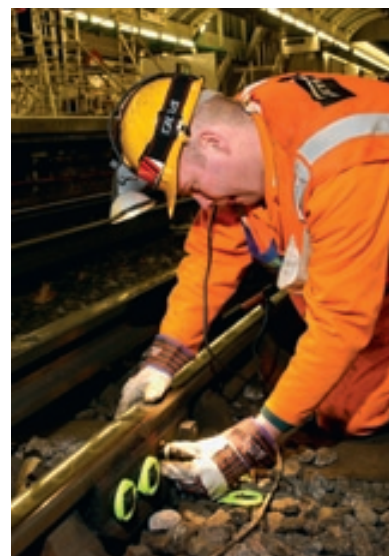
Nord-Locks unika låsbrickor används för att uppgadera säkerheten på Londons tunnelbananät. Låsbrickorna förhindrar att vibrationer lossar rälsförbanden.
