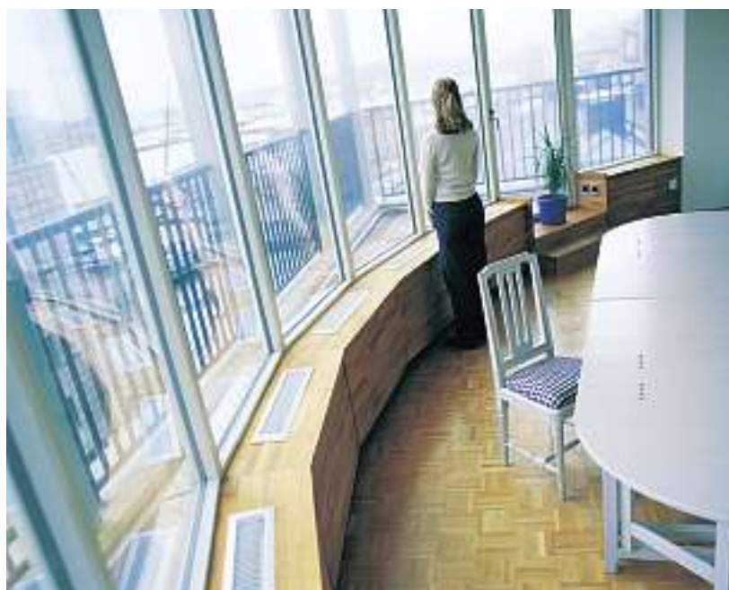
I fönsterbänkarna hos Länsstyrelsen i Göteborg är STIFAB FAREX fönsterapparater för värme, kylning och ventilation placerade.
