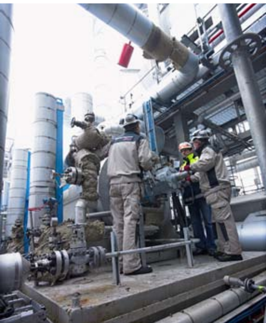
Underhållsarbete på raffinaderi.
